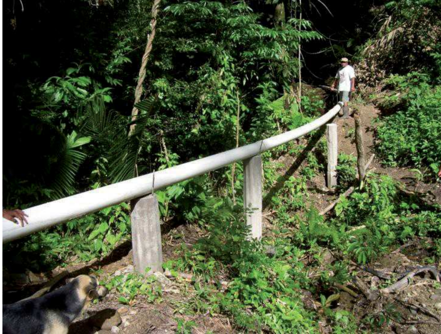
FIGURA 7. Instalación de soportes para salvar la distancia entre la tubería forzada y las irregularidades del terreno
