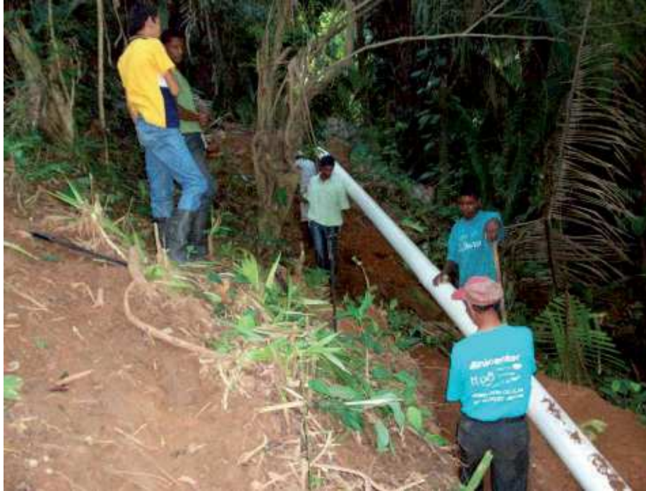
FIGURA 6. Instalación de la tubería forzada
