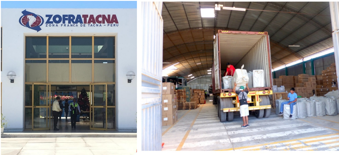
Figura 16. Infraestructura de la empresa Zofratacna como centro logístico y almacenamiento en la ciudad de Tacna, Perú.
