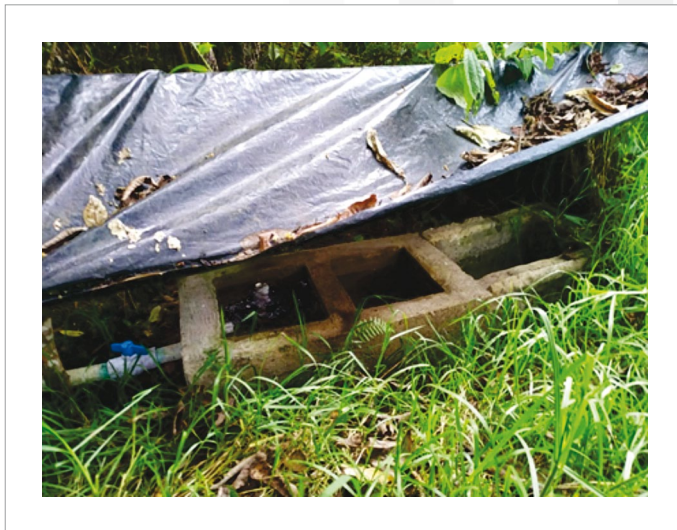
Figura 57 Desarenador actual del acueducto Tunjaque.
