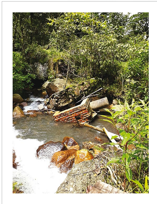
Figura 31 Ubicación de la bocatoma de fondo removida.
