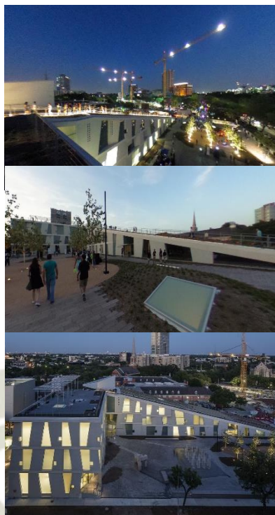
Figura N° 76 Vista exterior de la Escuela de Arte Glassell, Houston.
