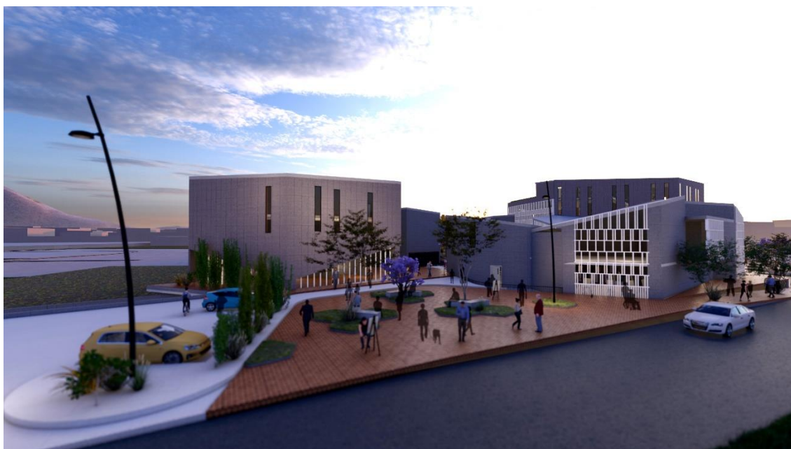
Figura N° 264 Vista lateral de estacionamientos
