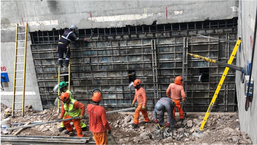
Figura 54. Encofrado con paneles fenólicos de paños de esquina (Fuente. Registro fotográfico de la obra Camino Real)
