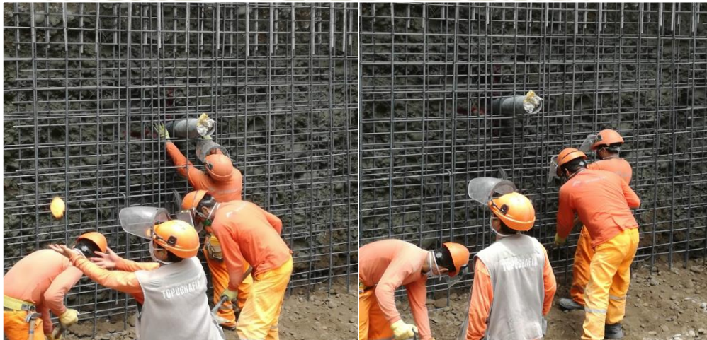
Figura 50. Colocación de tubo para el anclaje (Fuente. Registro fotográfico de la obra Camino Real)
