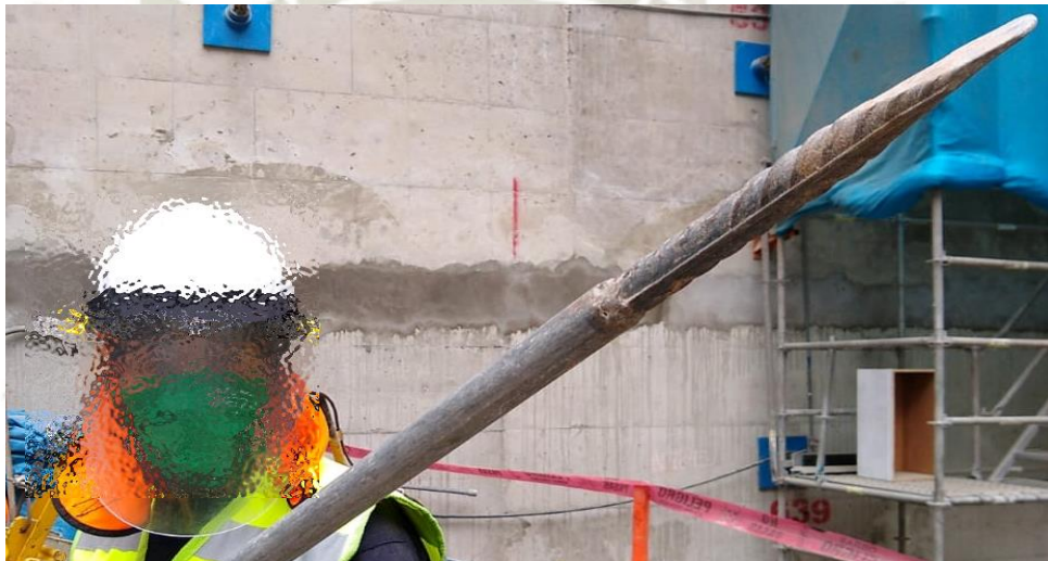
Figura 59. Barreta de concreto con punta metálica (Fuente. Registro fotográfico de la obra Camino Real)
