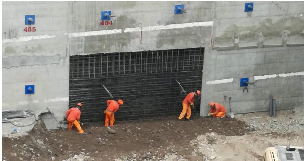
Figura 51. Colocación de superficie para encofrado (Fuente. Registro fotográfico de la obra Camino Real)
