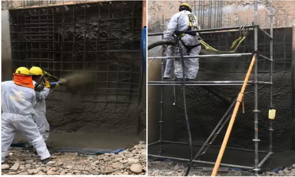
Figura 66. Izquierda, Lanzado de Shotcrete; Derecha, Lanzado de Shotcrete desde el andamio (Fuente. Registro fotográfico de la obra Camino Real)
