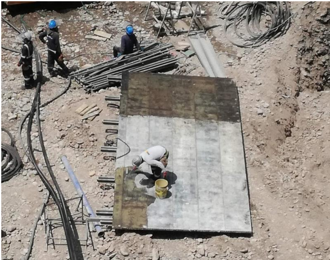
Figura 52. Preparación y traslado de encofrado con paneles fenólicos (Fuente. Registro fotográfico de la obra Camino Real)
