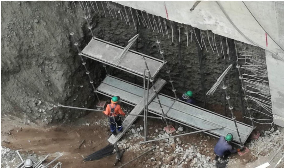
Figura 45. Habilitación de andamio (Fuente. Registro fotográfico de la obra Camino Real)
