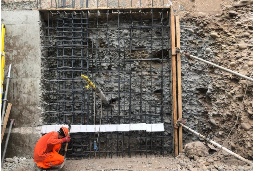
Figura 65. Colocación de tecnopor (Fuente. Registro fotográfico de la obra Camino Real)
