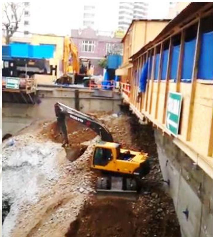
Figura 4. Eliminación por el método de pasamanos con el uso de banqueta o montículo (Fuente. Registro fotográfico obra Camino Real)
