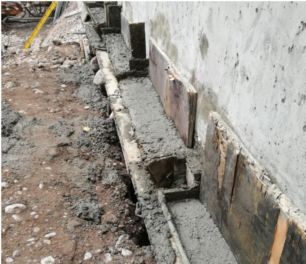
Figura 55. Vaciado con ayuda de la Cachimba
