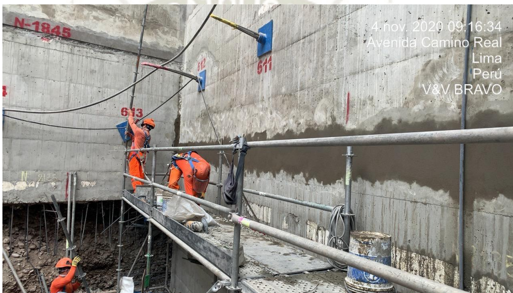
Figura 57. Resanes (Fuente. Registro fotográfico de la obra Camino Real)
