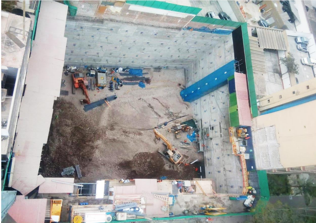
Figura 13. Vista en planta de la obra Camino Real (Fuente: Registro fotográfico de la obra Camino Real)
