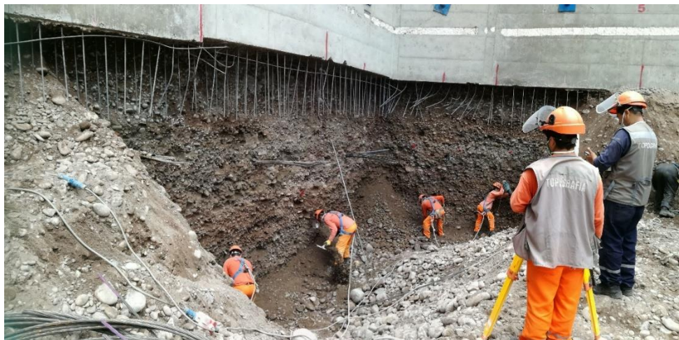
Figura 43. Perfilado del paño o excavado manual (Fuente. Registro fotográfico de la obra Camino Real)
