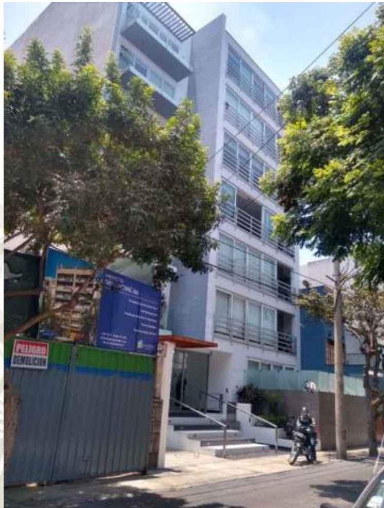
Figura 17. Vista de la propiedad del vecino lado derecho, adyacente al eje 6-6 del proyecto ( Fuente: Adaptado de Google Maps, 2021 )
