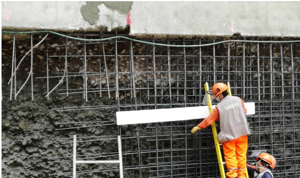
Figura 49. Colocación de tecnopor (Fuente. Registro fotográfico de la obra Camino Real)
