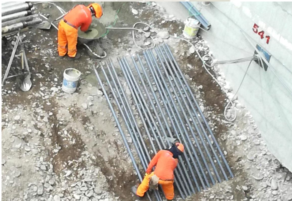
Figura 62. Tubos de PVC rellenos de concreto (Fuente. Registro fotográfico de la obra Camino Real)
