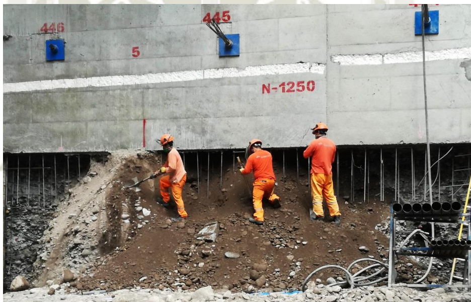
Figura 41. Encuentro con empalme de barras de acero (Fuente: Registro fotográfico de la obra Camino Real)
