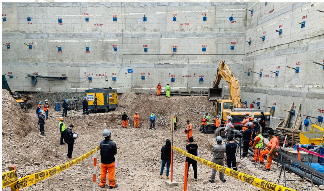
Figura 19. Charlas de seguridad con el cumplimiento del distanciamiento de 1.5m (Fuente: Registro fotográfico de la obra Camino Real)
