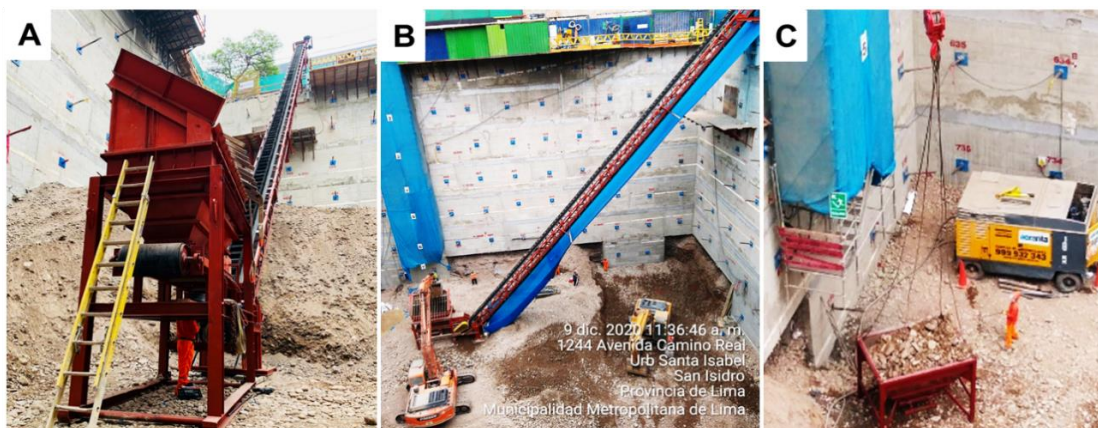
Figura 82. Funcionamiento del método faja transportadora y grúa balde (Fuente. Registro fotográfico de la obra Camino Real)
