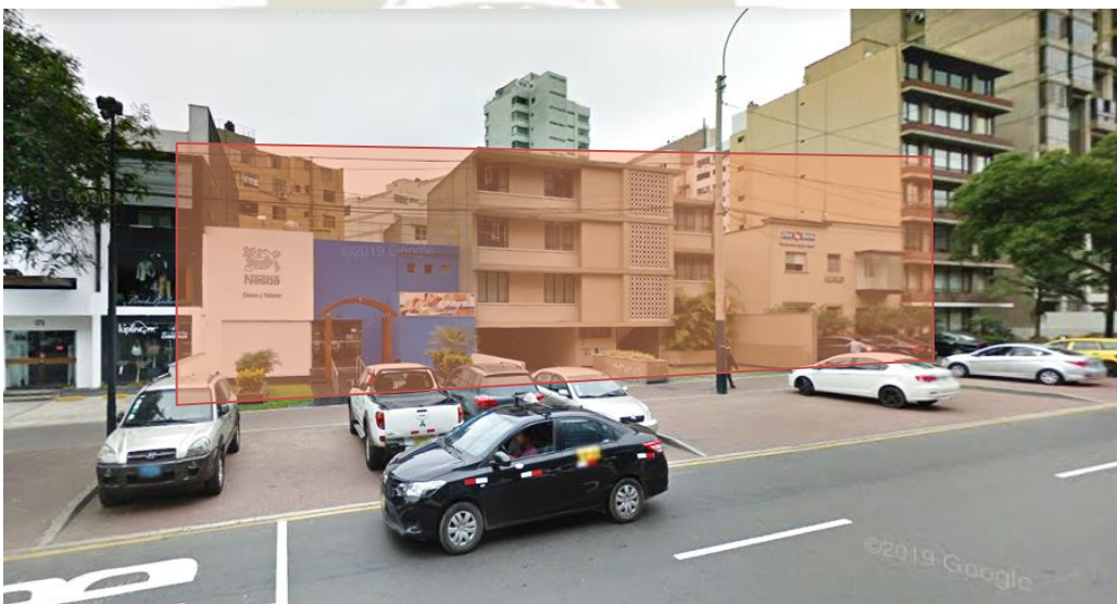
Figura 14. Edificaciones Existentes que pertenecían al terreno del proyecto Camino Real (Fuente: Adaptado de Google Maps, 2021)
