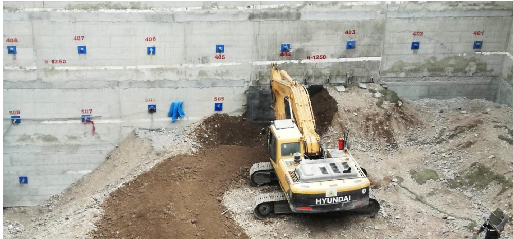
Figura 61. Desenterrado de muro (Fuente. Registro fotográfico de la obra Camino Real)
