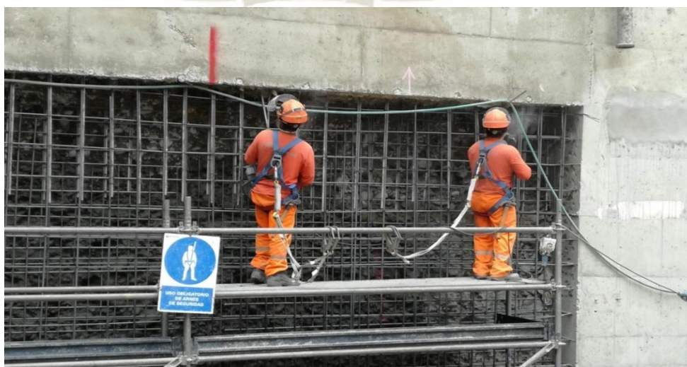
Figura 40. Limpieza de rebada de concreto sucio luego de la instalación de la malla de acero (Fuente: Registro fotográfico de la obra Camino Real)
