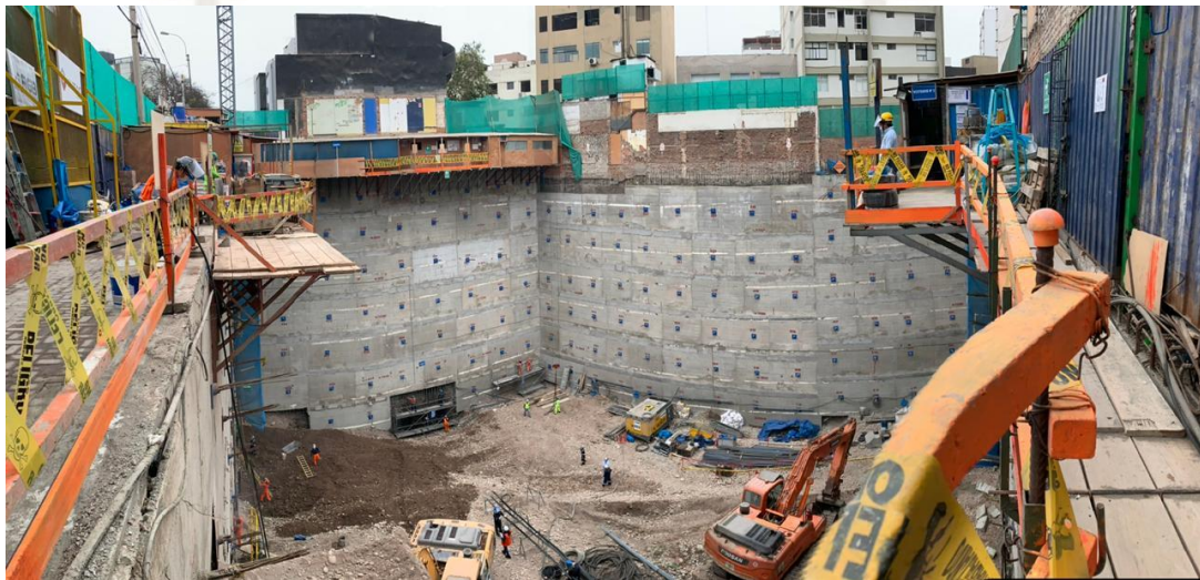
Figura 11. Vista de la excavación profunda de hasta 30.55 m, con un área de terreno de 1,487.65 m 2 (Fuente: Registro fotográfico de la obra Camino Real)
