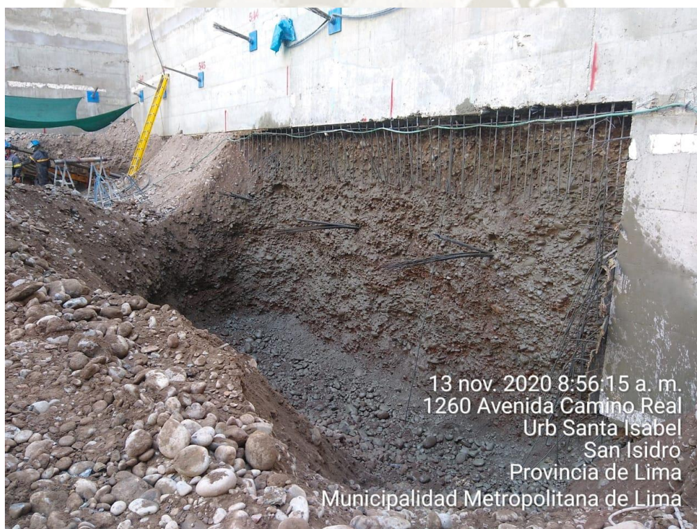
Figura 44. Distribución de la lechada de concreto (Fuente. Registro fotográfico de la obra Camino Real)
