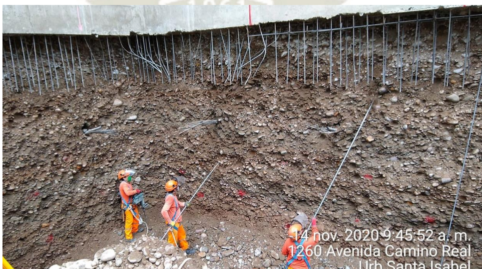
Figura 60. Perfilado de muro con barreta de concreto con punta metálica (Fuente. Registro fotográfico de la obra Camino Real)
