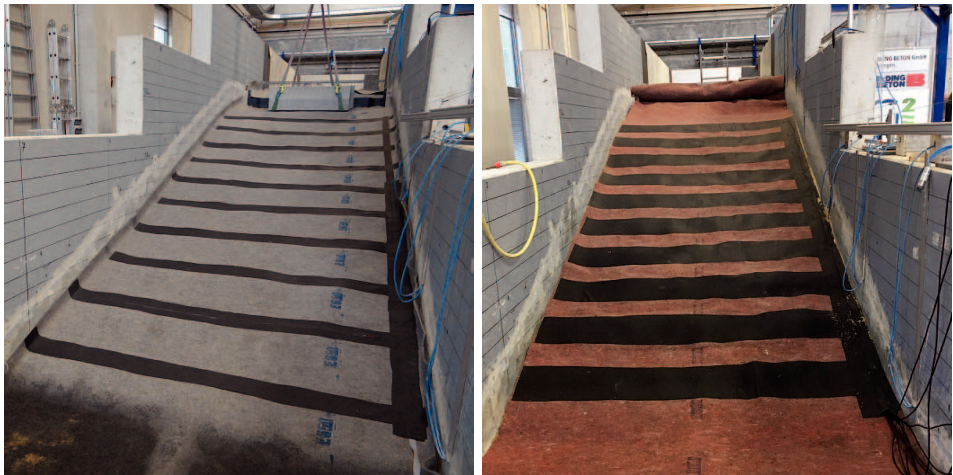
Abbildung 17: Im großen Modelldeich eingebaute Messvliese (links: Messvlies III, Einbau im August 2017; rechts: Messvlies IV, Einbau im November 2017).
