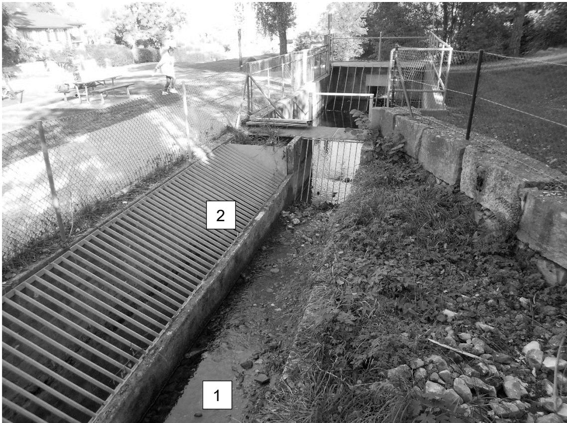
Abb. 1: Die bestehende HWE mit der nicht sichtbaren Fussgängerbrücke (1) und dem Streichwehr (2) in Dielsdorf (Blick in Fließrichtung)
