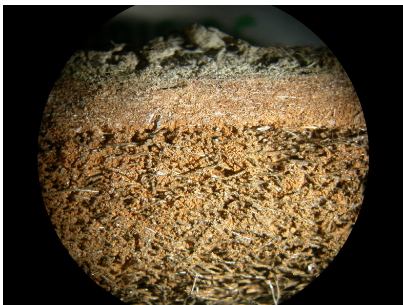
Bild 1: Verockerter geotextiler Filter (Tideems), Schnitt.
