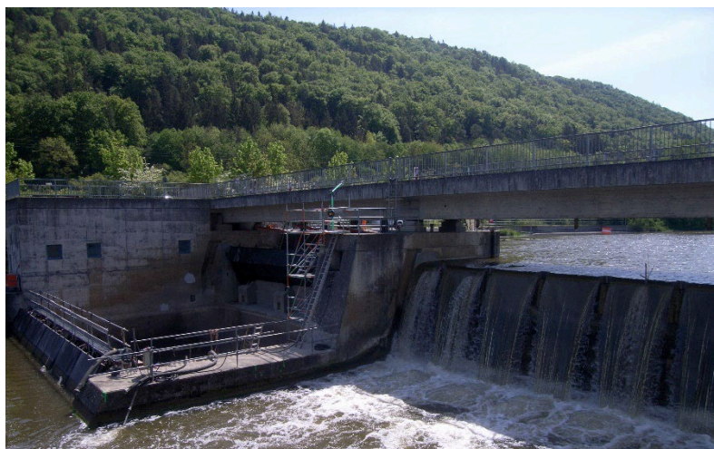
Bild 1: Zur Bauwerksinspektion trockengelegtes Wehrfeld der Wehranlage Dietfurt.
