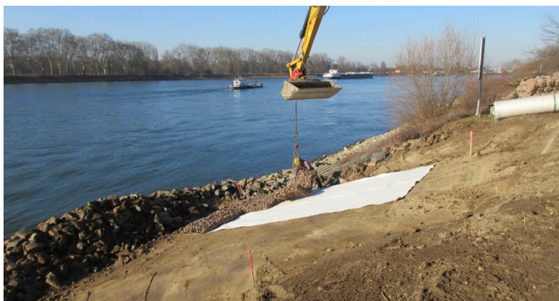
Bild 1: Einbau des neu entwickelten Geotextils am Rhein, Februar 2020.
