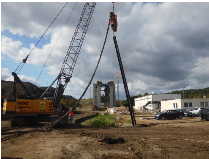
Bild 1: Ausgerüttelter Probepfahl.
