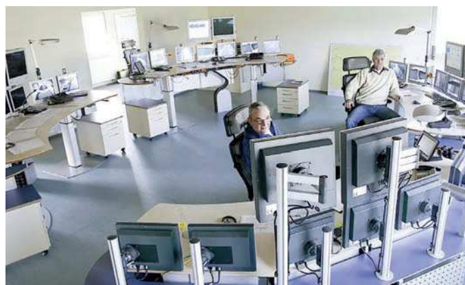
Bild 5: Leitzentrale Haßfurt mit vier Steuerständen
