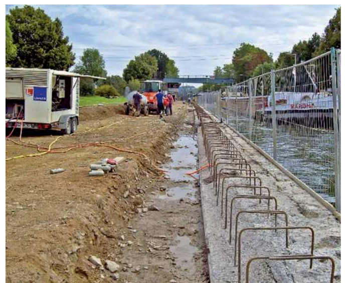
Bild 9: Erneuerung des Kantenschutzes an der Schleuse Goßmannsdorf
