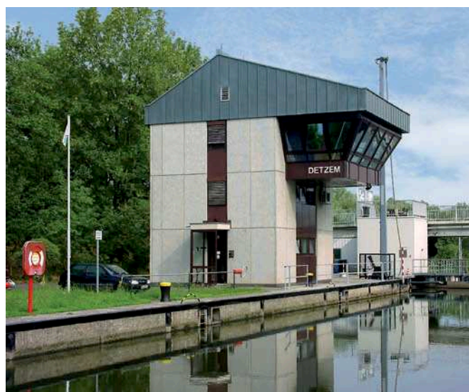
Bild 3: Schleusenbetriebsgebäude Schleuse Detzem (Mosel)
