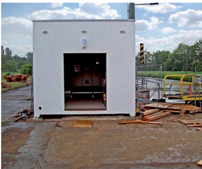
Bild 7: Fertigteilgarage als neues Antriebshaus an der Schleuse Dettelbach
