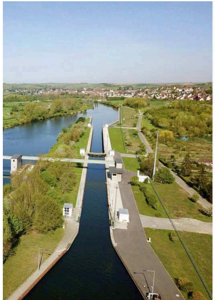
Bild 8: Schleuse Dettelbach nach Abschluss der Instandsetzungsarbeiten
