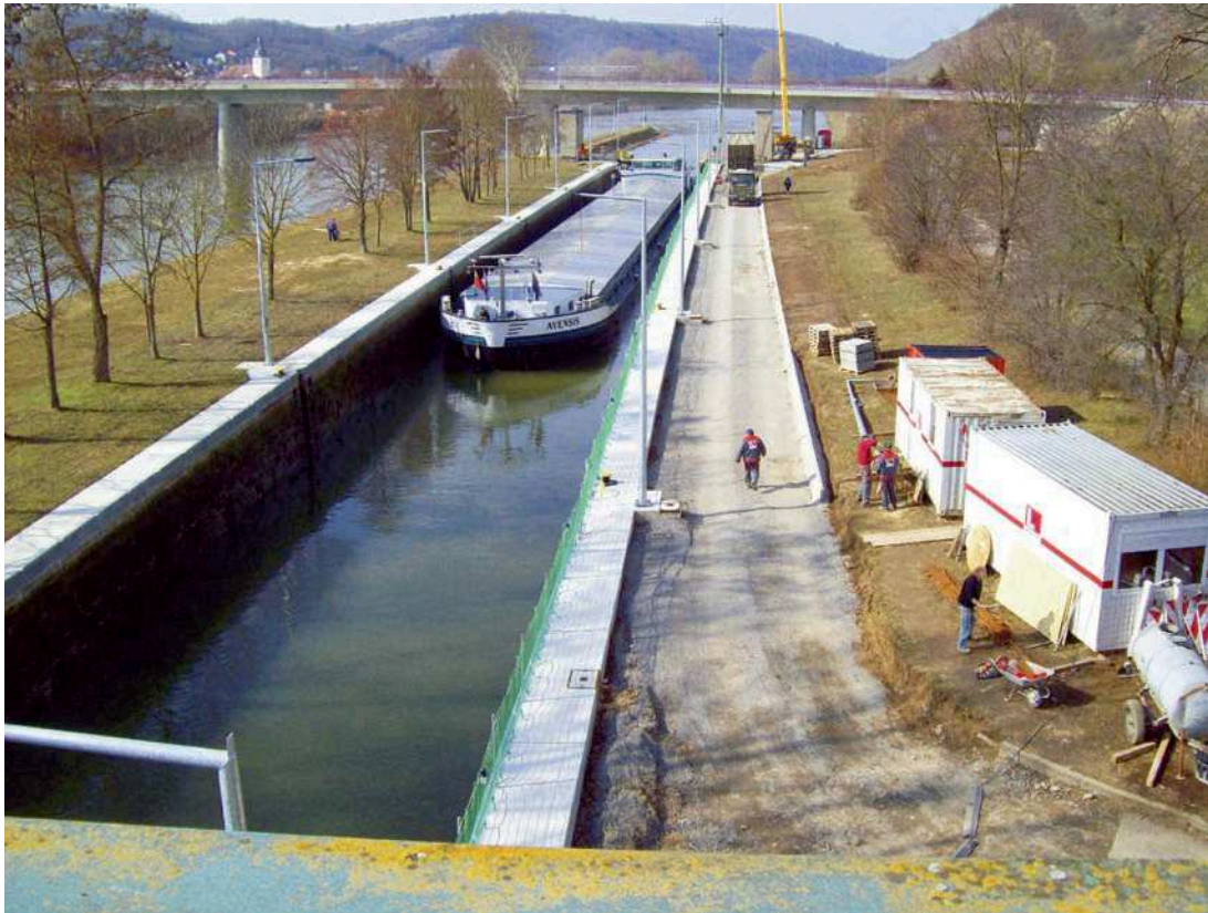
Bild 10: Erneuerung der Schleusenplanie an der Schleuse Goßmannsdorf
