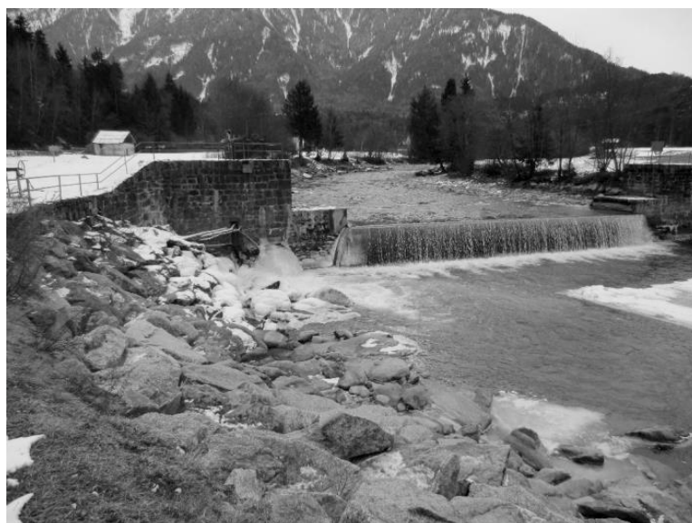
Abb. 1: Öztaler Ache vor Baudurchführung am bestehendem Wehr Brunau bei Niederwasser
