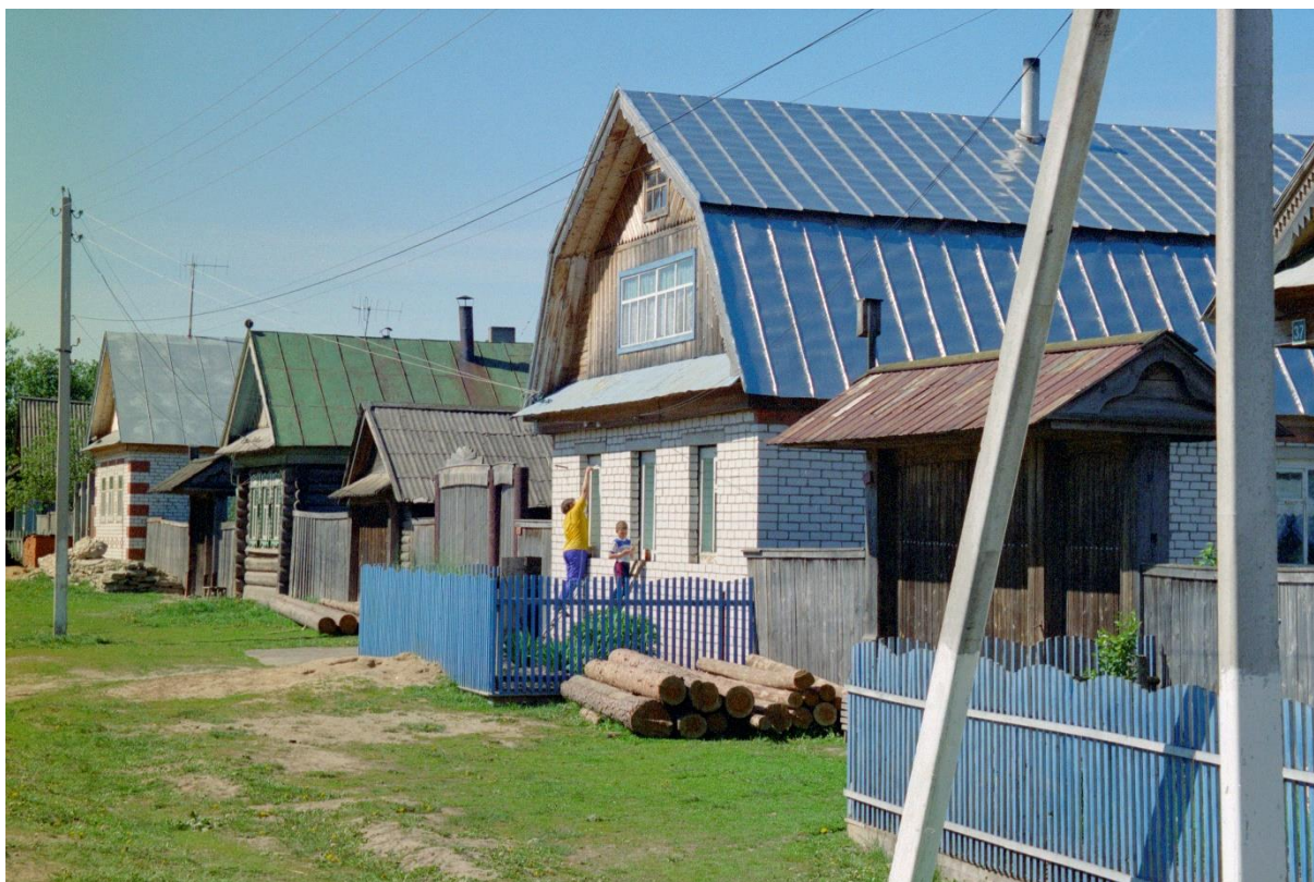
Kuva 5 Vanhempia hirrestä ja uudempia tiilestä tehtyjä rakennuksia Untšossa 12.6.2002. Kyläläiset siistivät ja kunnostavat taloja tulevaa juhla-kautta varten. Kuva: Mari Aaltonen.
