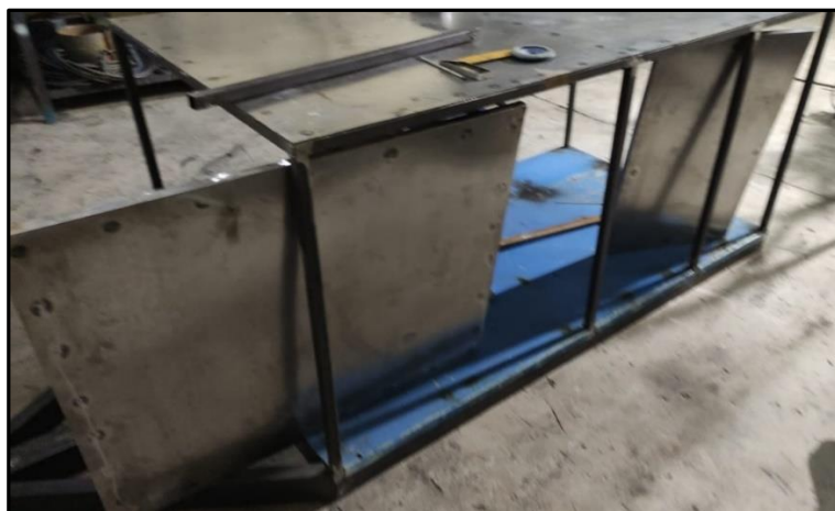
Figura 3.15 Fabricación de las compuertas y cubierta de la carrocería
