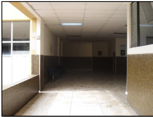
Figura 40. Área de farmacia del Hospital de Ibarra – IESS Fuente: (Hospital de Ibarra - IESS, 2019)
