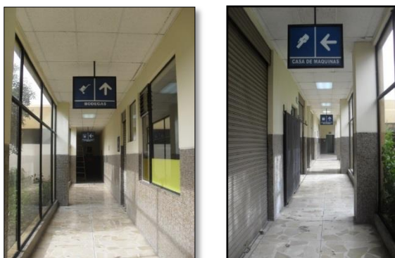
Figura 45. Área de Bodegas, Dietas y Lavandería del Hospital de Ibarra – IESS Fuente: (Hospital de Ibarra - IESS, 2019)
