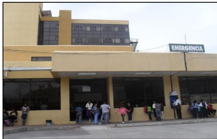
Figura 36. Entrada y salida área de emergencia Fuente: (Hospital de Ibarra - IESS, 2019)
