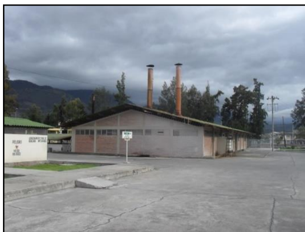
Figura 37. Cuarto de máquinas Fuente: (Hospital de Ibarra - IESS, 2019)
