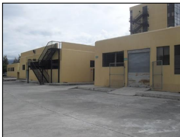
Figura 38. Entrada a Morgue, bodega y lavandería Fuente: (Hospital de Ibarra - IESS, 2019)
