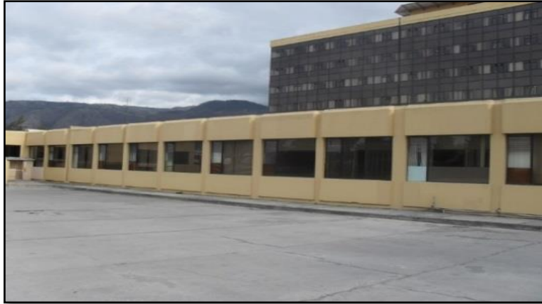
Figura 35. Parqueadero secundario del Hospital de Ibarra – IESS Fuente: (Hospital de Ibarra - IESS, 2019)
