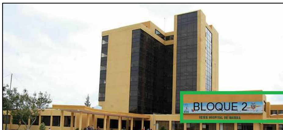
Figura 17. Primer piso – bloque 2 del Hospital de Ibarra - IESS Fuente: (Hospital de Ibarra - IESS, 2019)
