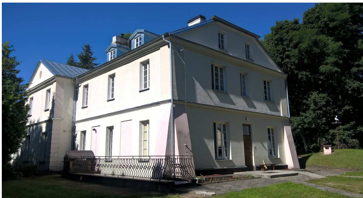
Fot. 36. Ściana wschodnia (tył) i północna dworu ufundowanego przez Ludwika Świdarskiego w Kodniu, widok współczesny (VII 2017)
