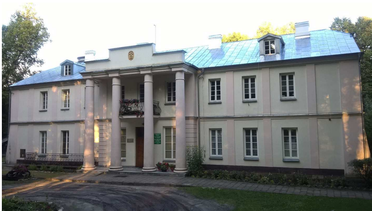
Fot. 35. Ściana zachodnia (front) dworu ufundowanego przez Ludwika Świdarskiego w Kodniu, widok współczesny (VII 2017)
