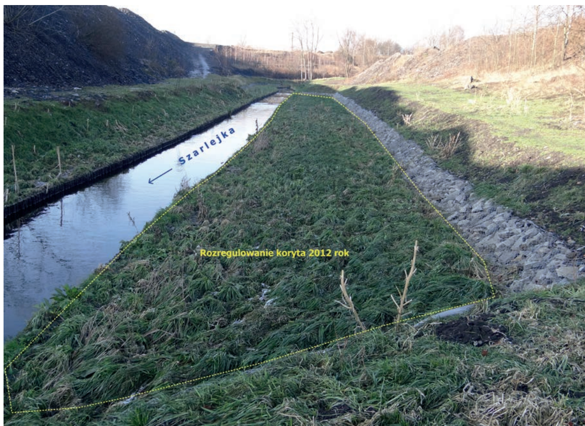
Fot. 5. Przeobrażenie doliny Szarlejki przez składowanie skały płonnej. Fragment „rozregulowanego” koryta rzeki w wyniku działań prowadzących do renturyzacji rzeki Szarlejki
