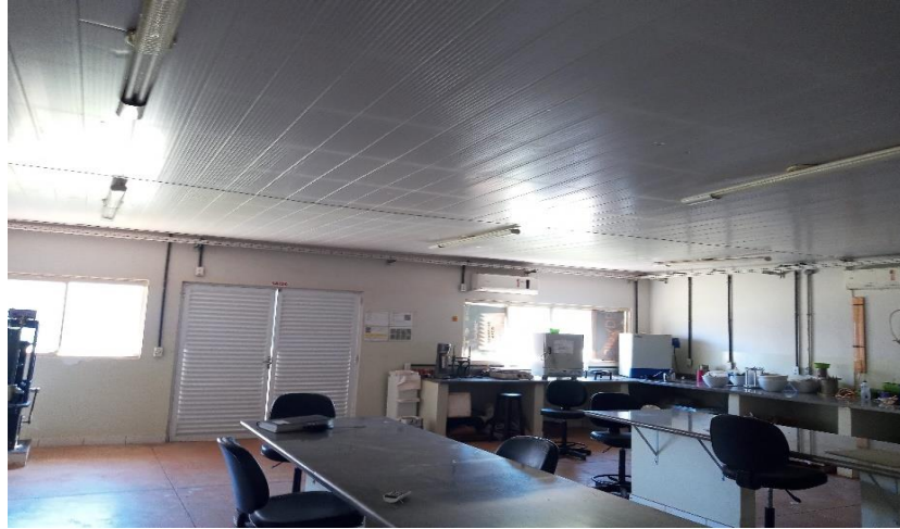
Figura 16: Forro de PVC no Laboratório de Mecânica dos Solos
