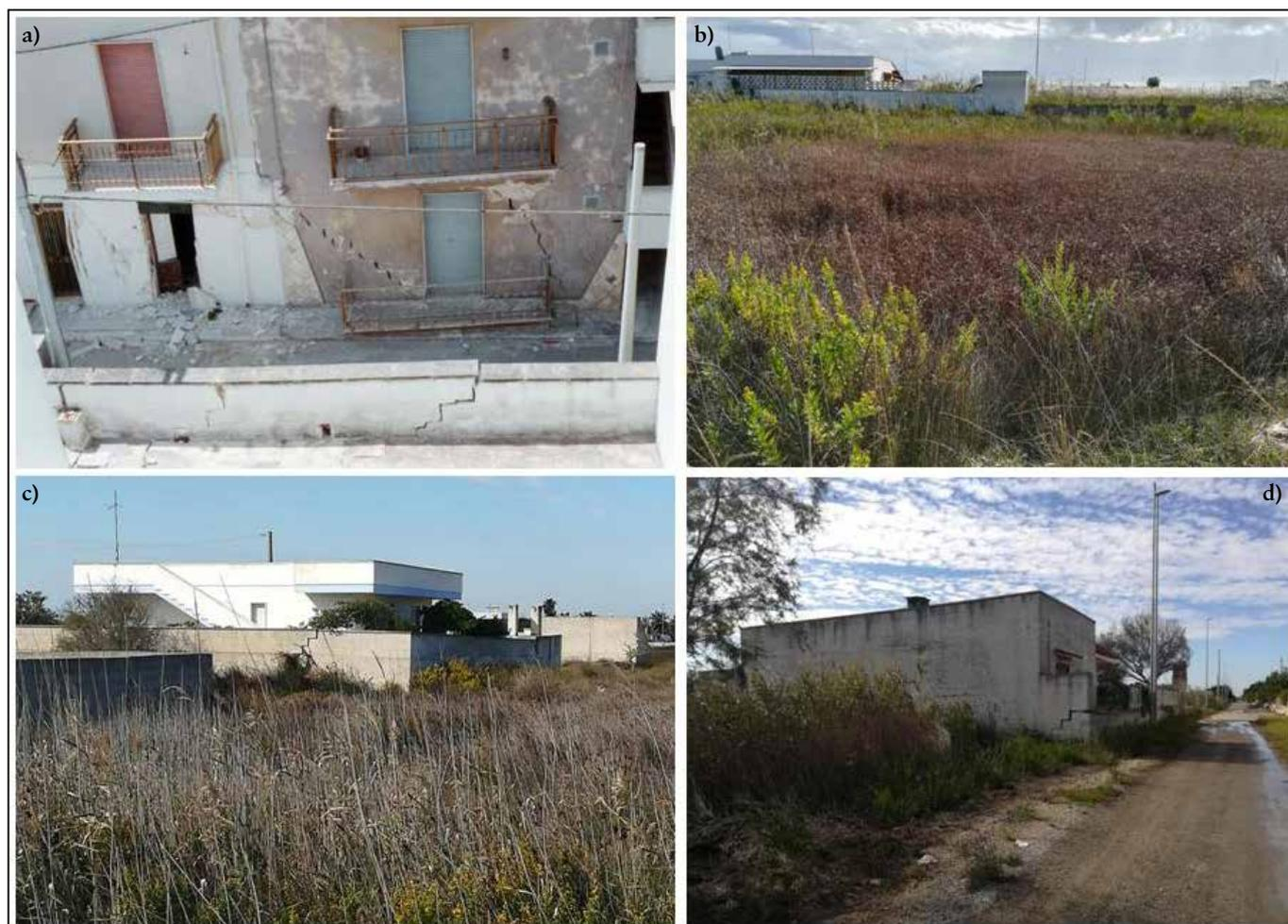
Figura 2 - Alcuni esempi di dissesti negli abitati di Casalabate (foto a, da Margiotta *et al.*, 2012), Torre Rinalda (foto b, con in primo piano un *sinkhole*, e c) e Spiaggiabella (foto d). Tutti questi abitati, così come parte di quello di Torre Chianca, sono ubicati in corrispondenza di originarie zone paludose.
