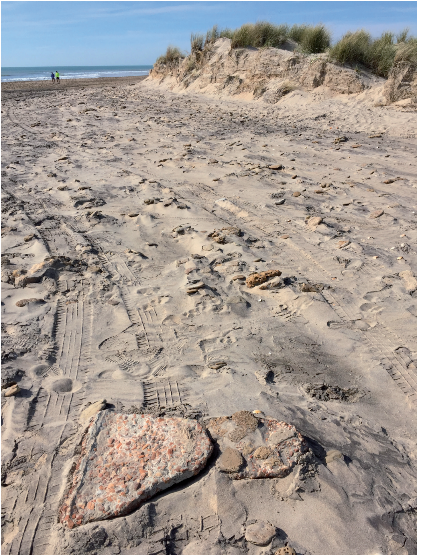
Figura 18. Imagen que muestra de forma muy explícita el deterioro y peligro de desaparición al que están expuestos los restos antiguos de la Playa de Camposoto (en este caso, fragmentos de cocciopesto y estructuras atropellados por los quads de los servicios de limpieza y vigilancia municipales).
