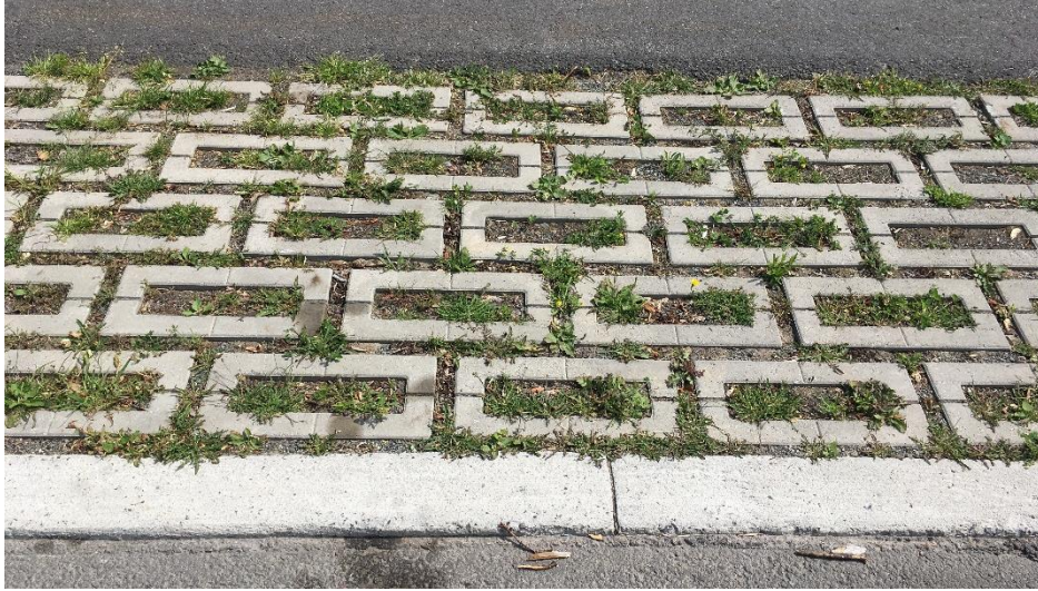
Figure 92: Pavé alvéolé le 8 juillet 2021
