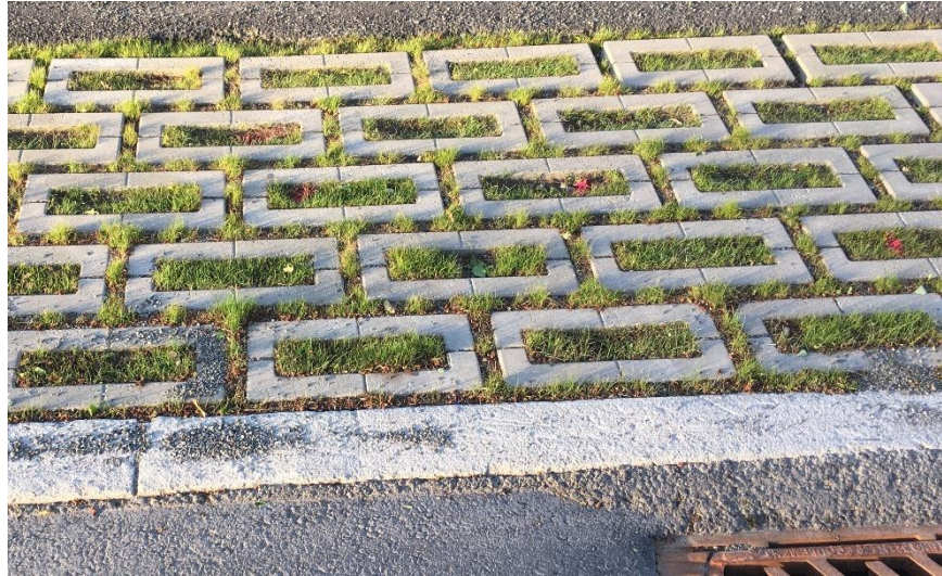
Figure 88: Pavé alvéolé le 11 juin 2020
