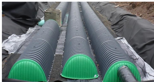
Figure 6: Vue des chambres de rétention pendant les travaux
