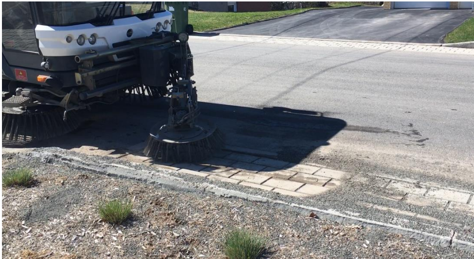
Figure 47: Entretien du printemps 2021: balayage en surface
