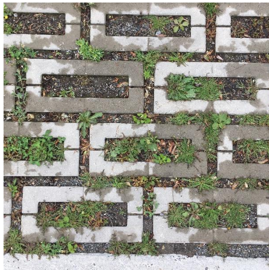
Figure 93: Pavé alvéolé le 9 juillet 2021
