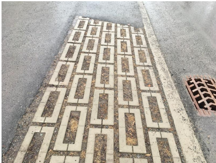
Figure 90: Pavé alvéolé le 26 mars 2021
