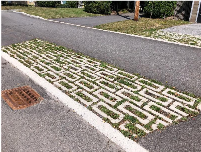
Figure 94: Pavé alvéolé le 15 août 2021
