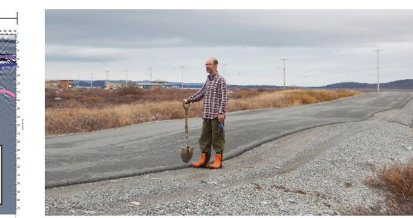
Figure 5 : Tassement différentiel observé le long de la route d'accès à l'aéroport, Tasiujaq. Tiré de L'Hérault et al., 2014.
