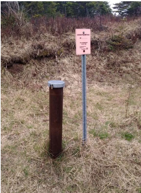
Puits F-1 du Réseau de suivi des eaux souterraines du Québec, à l'île de la Grande Entrée.
