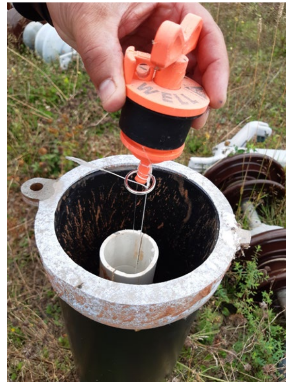
Puits HQ15-P4 d'Hydro-Québec, à l'île du Cap aux Meules.
