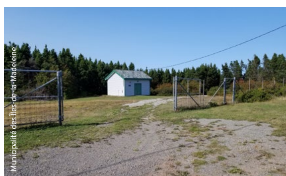
Aire de protection immédiate clôturée du puits P3, île du Havre Aubert.
