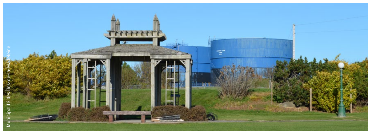
Entreposage de carburants lourds, centrale thermique, Cap aux Meules.
