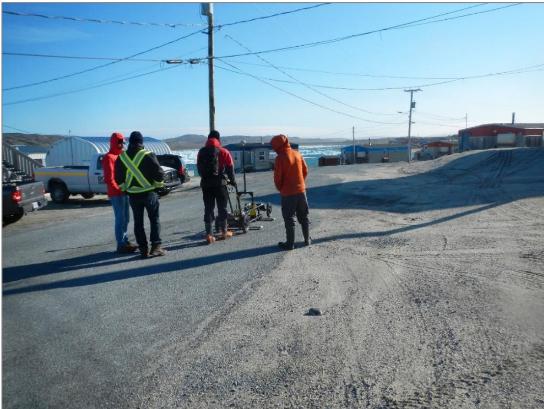
Figure 4 : Enregistrement de levés de géoradar sur les routes de la communauté d'Akulivik, août 2018
