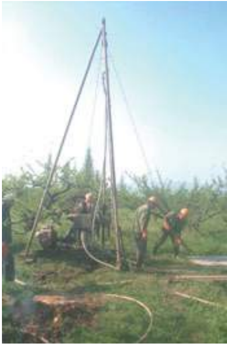
図8 ボーリング調査風景
