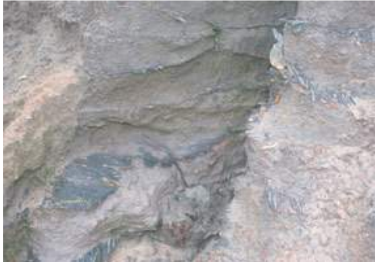
図 21 岡公嶺ダム構造体の草・衰・泥の痕跡
