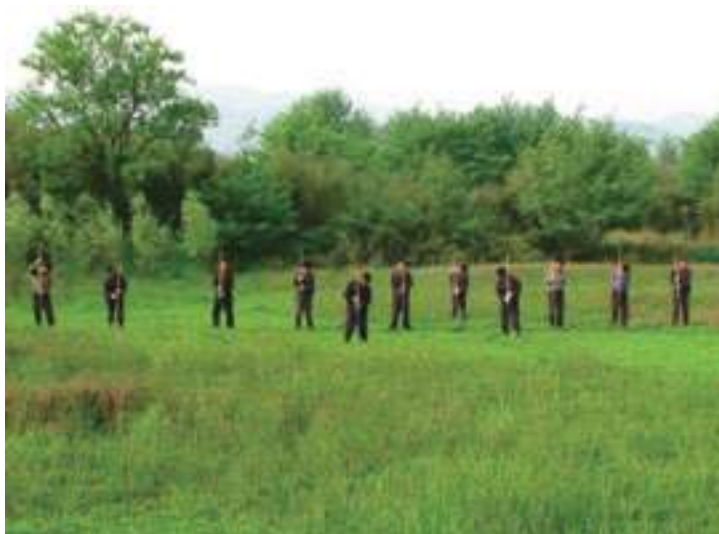
図6 ボーリング調査の状況
