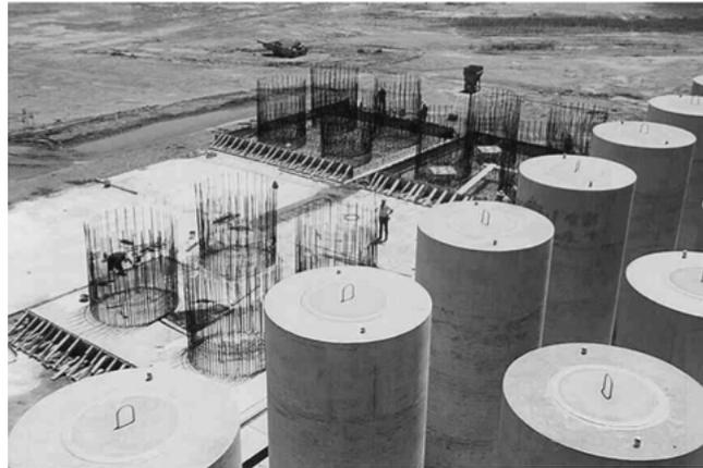
Figura 11 – Instalação de silos verticais de concreto armado em instalações externas.
