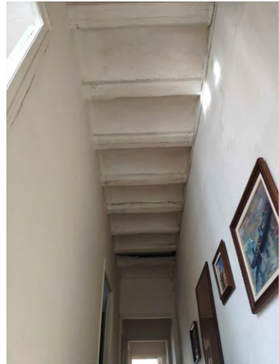
Sostre de voltes i vigues de fusta
