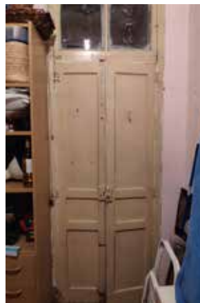
Portes dobles original habitacions
