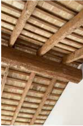
Sota coberta de vigues de fusta
