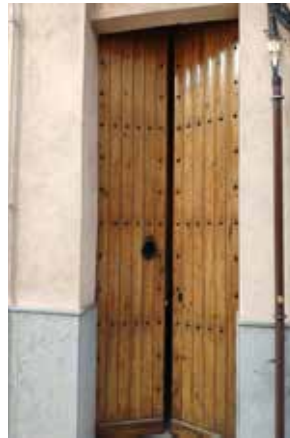
Portes dobles entrada principal
