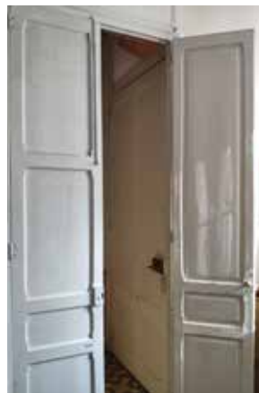
Portes dobles original habitacions
