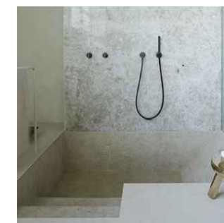
Banyera d'obra revestida en Kerakoll
