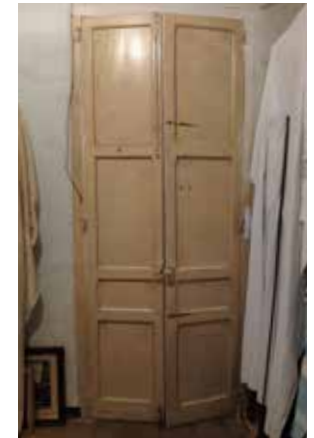
Portes dobles original habitacions
