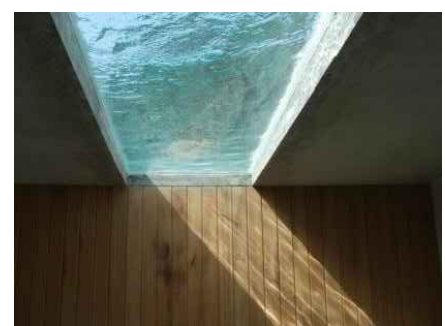
Obertura en forjat, vidre fix sota làmina d'aigua
