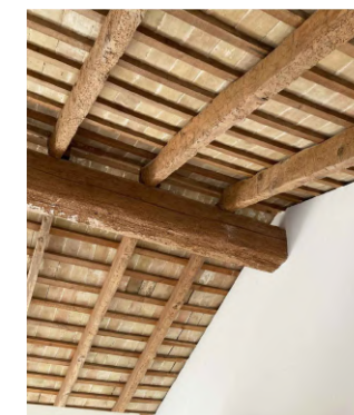
Sotacoberta original vista
