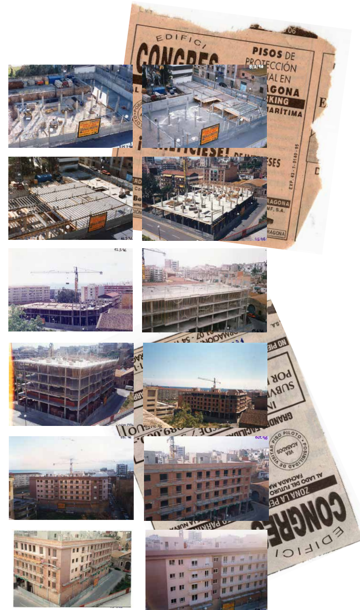
IMATGE 1. Imatges documentant l'edifici en construcció
