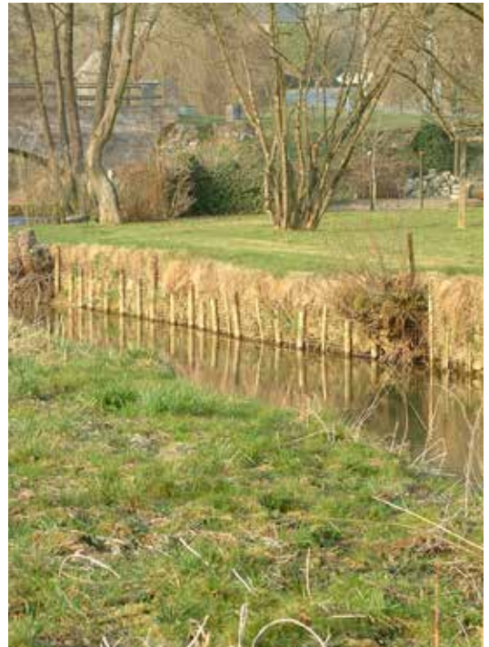
Photo 98. Tunage, Mehaigne, Braives, mars 2003 (50,62°N, 5,15°E) (Région wallonne, Direction des Cours d'eau non navigables).
