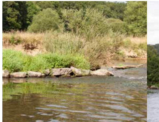
Photo 96. Même chose sur la Meuse ! Waulsort, août 2013 (Région wallonne, Équipement et Transports).
