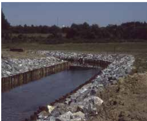
Photo 91. Reprofilage de l'Eau Blanche, Virelles, juin 1989 (Services techniques provinciaux).
