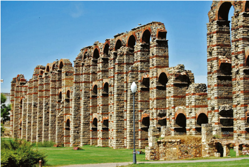
FIGURE 8.4 Acueducto de los Milagros, Mérida, España
