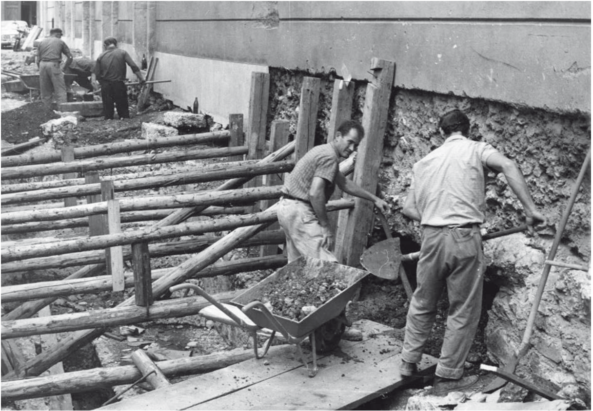
Sl. 8: Župna cerkev v Kranju l. 1972, pogled na izkopno polje (avtor neznan; izvornik hrani Gorenjski muzej Kranj).
