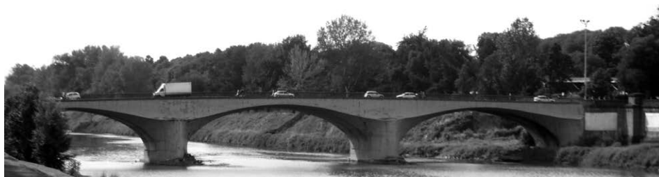
Fig. C-29. The Ponte alla Vittoria in its present shape.
