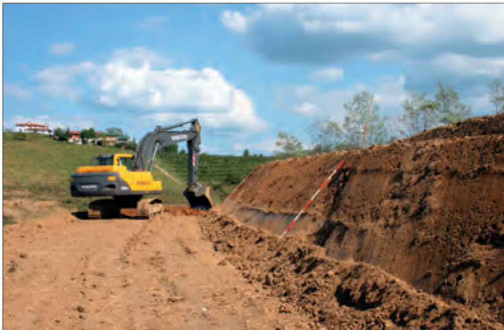
Slika 111: Zemeljska dela pri terasiranju pobočja so bila v celoti izvedena z buldožerji in bagri.
