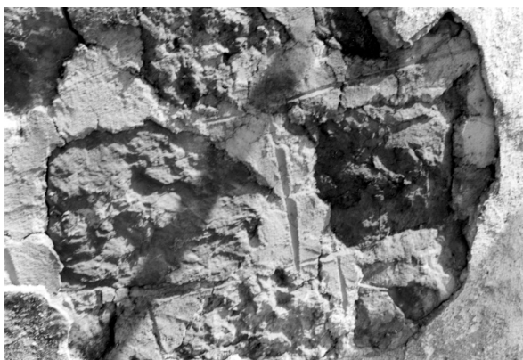
Sl. 4.15: Mali grad, kapela, podrobnost zidave zidu 3 iz delno obdelanih peščenjakovih lomljencev v tehniki plastene zidave s črnimi fugiranjem (dokumentacija ZVKDS, OE Kranj, fotografija N. Leben).
