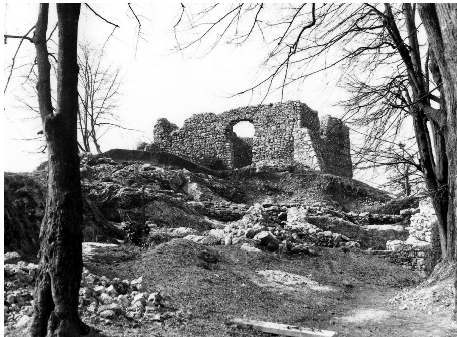
Sl. 3.3: Mali grad, izkopavanja leta 1981, pogled na izkopno polje; v ozadju stolp poznosrednjeveške mestne utrdbe pred restavriranjem (dokumentacija ZVKDS OE Kranj, fotografija M. Sagadin).
