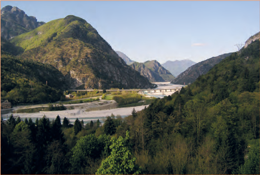
Prometno in infrastrukturno obremenjena Železna dolina ob reki Beli. Foto: Primož Pipan.
