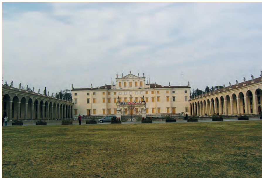
Pročelje vile Manin z arkadnima hodnikoma. Foto: Primož Pipan.
