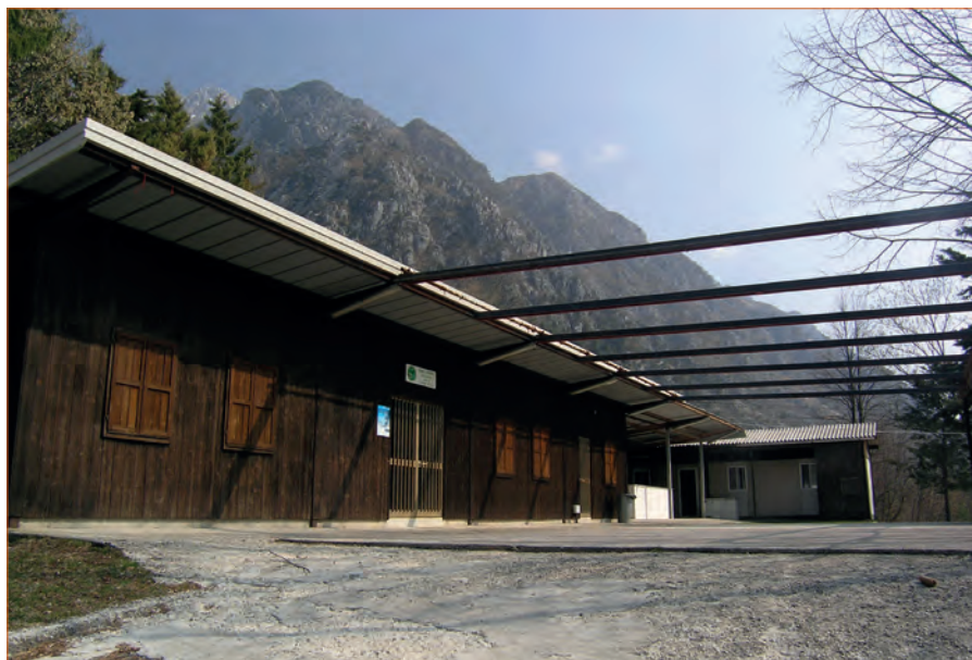
Po končani popotresni obnovi so mnogi zasilni montažni objekti postali prazni. Foto: Primož Pipan.
