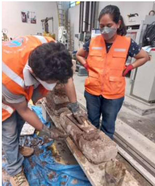
Figura 14: Asentado de los adobes
