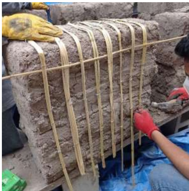
Figura 18: Colocación de cañas en sentido horizontal
