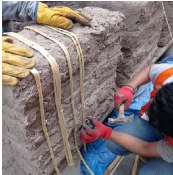
Figura 18: Colocación de cañas en sentido horizontal
