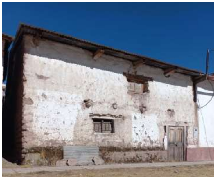
Figura 3: Viviendas de adobe de dos niveles
