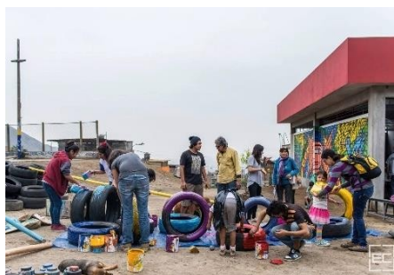
Imagen 11. FITEKA en la intervención de su local comunal
