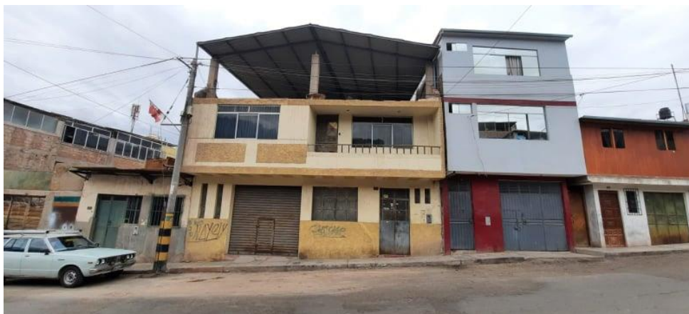
Figura 44. Viviendas de albañilería confinada
