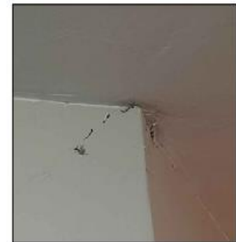
ESTADO ACTUAL DE LA VIVIENDA
