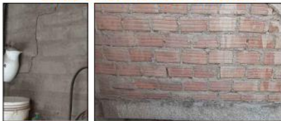
ESTADO ACTUAL DE LA VIVIENDA
