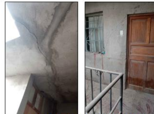
ESTADO ACTUAL DE LA VIVIENDA
