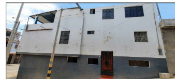
ESTADO ACTUAL DE LA VIVIENDA
