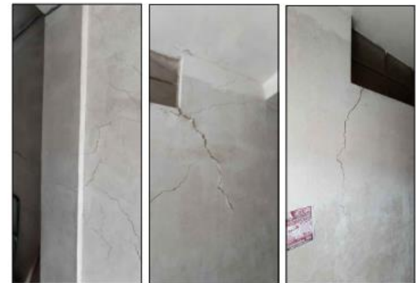
ESTADO ACTUAL DE LA VIVIENDA
