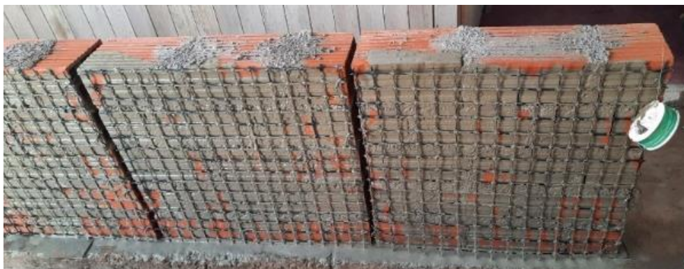
Figura 6. Tarrajeo de muretes reforzados con geomalla biaxial.
