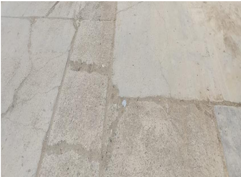
Figura 8 Falla de descascaramiento de esquina
