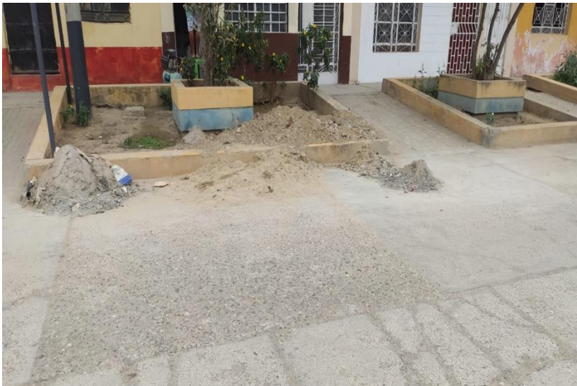
Figura 7 Falla de pulimiento de agregados
