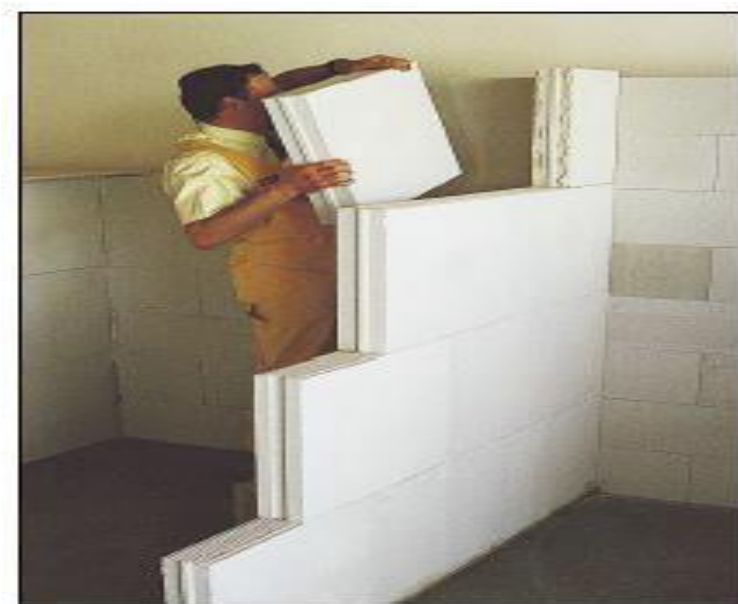
Figura 2. Colocación de bloque apilable
