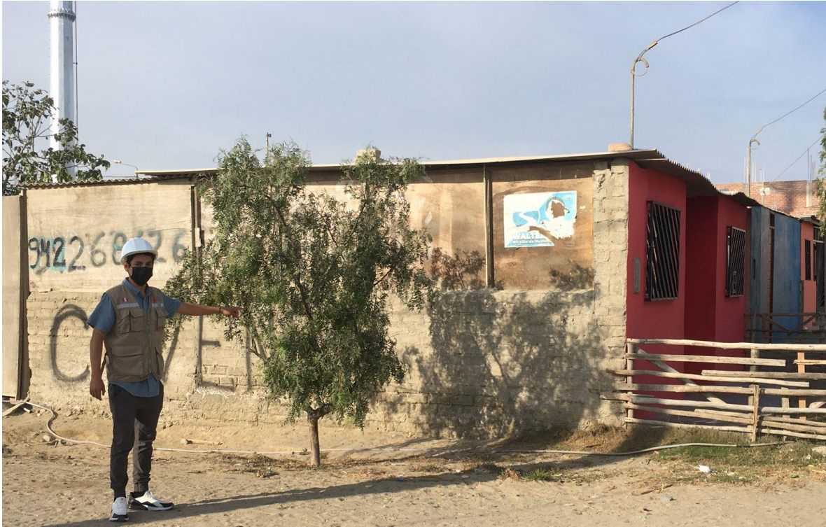
FIGURA 9.-Presencia de viviendas contruidas sin presencia de elementos estructurales.
