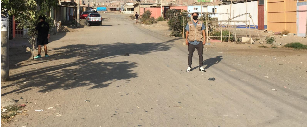
FIGURA 7.- Presencia de viviendas contruidas con material rustico
