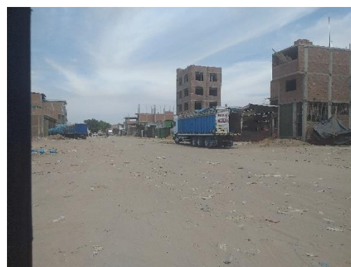
Calles perimetrales en mal estado
