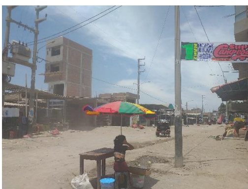
Infraestructura en malas condiciones
