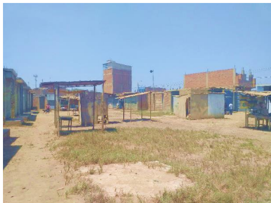
Infraestructura en mal estado – Pisos
