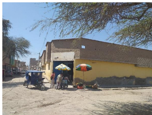
Calles perimetrales en mal estado
