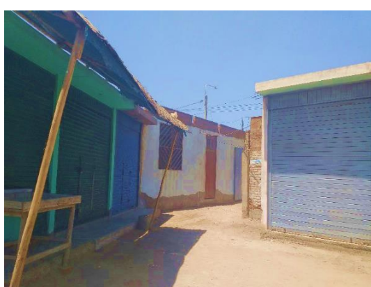
Infraestructura en mal estado
