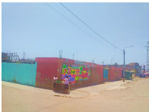
Infraestructura en mal estado
