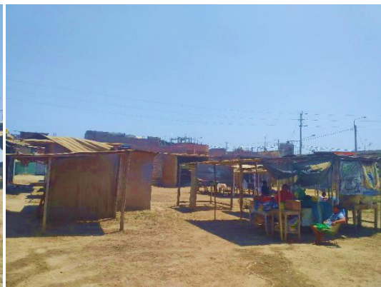
Infraestructura en mal estado – Tipologías de Puestos de venta
