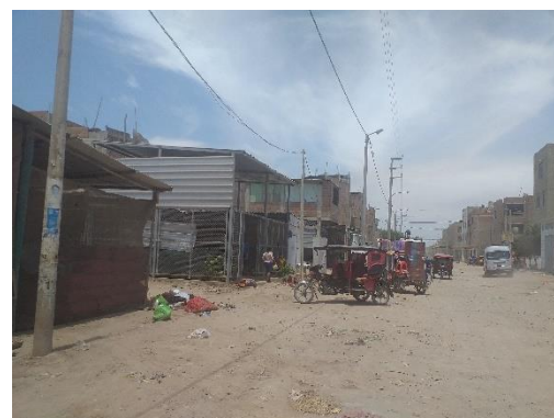
Calles perimetrales en mal estado
