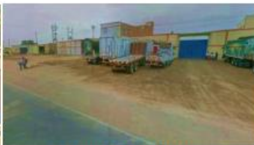
2. Terminalales terrestres, incluido el terminal Marañón
