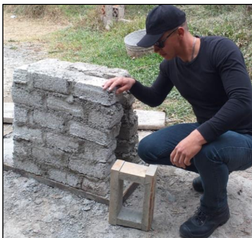
Figura 44: Fabricación del murete
