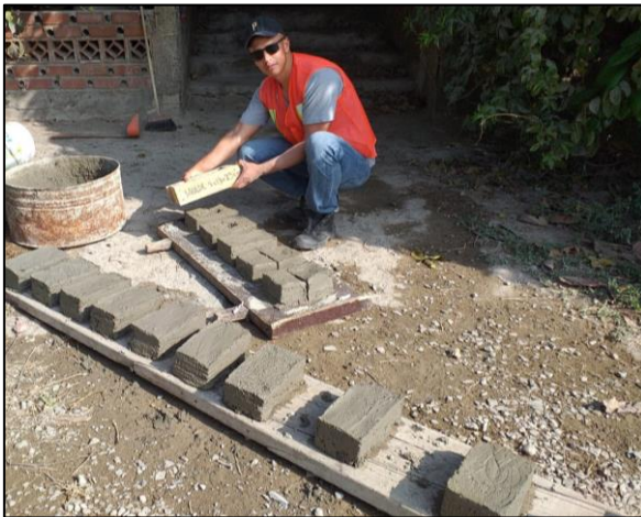
Ladrillos para los muretes
