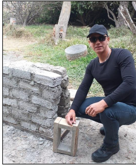
Fabricación de murete
