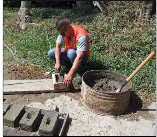
Relleno del molde con concreto
