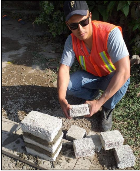
Construcción de pila
