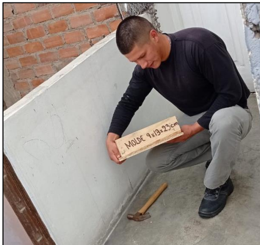
Fabricación del molde de ladrillos
