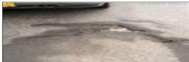
Figura 19. Grieta Parabólica
