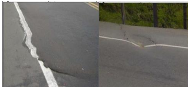
Figura 4. Abultamientos y Hundimientos
