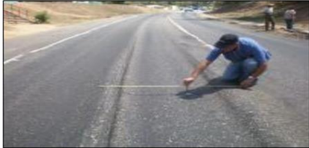
Figura 7. Ahuellamiento
