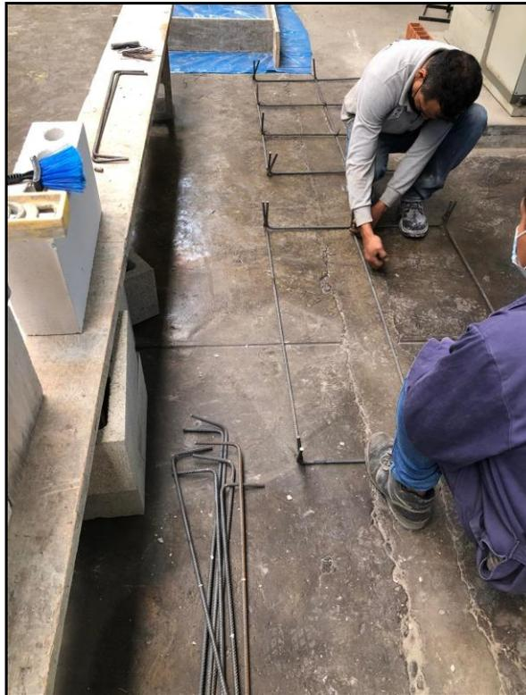
6. Colocación de los aligerantes y del acero de refuerzo dentro del encofrado respetando el recubrimiento indicado de  $r=3\text{cm}$ .
