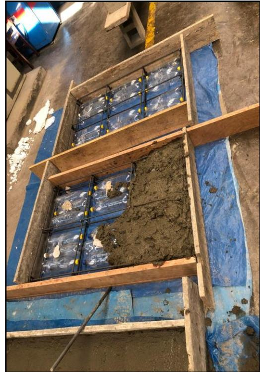
**8. Paleteado (vibrado) para una distribución uniforme del concreto dentro de la losa y así evitar cangrejas.**
