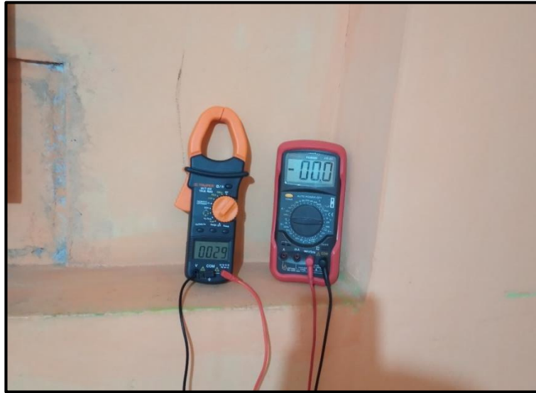
Instrumentos utilizados en la medición de los parámetros eléctricos del SF, multímetros marca PRASEK y TRUPER.
