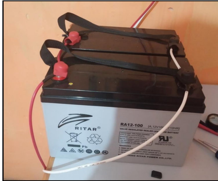
Banco de baterías de 12 voltios y 100 Ah de capacidad cada uno.
