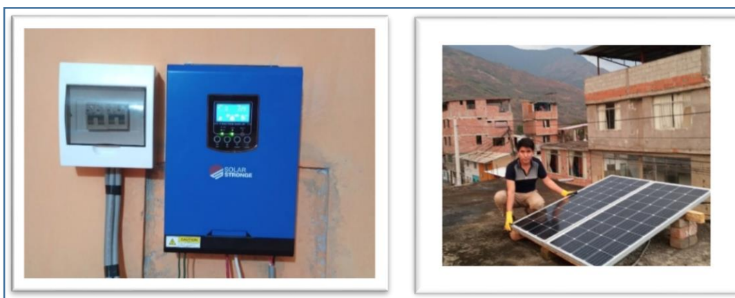
Figura 11: instalación de los componentes del sistema fotovoltaico de instalación híbrida.
