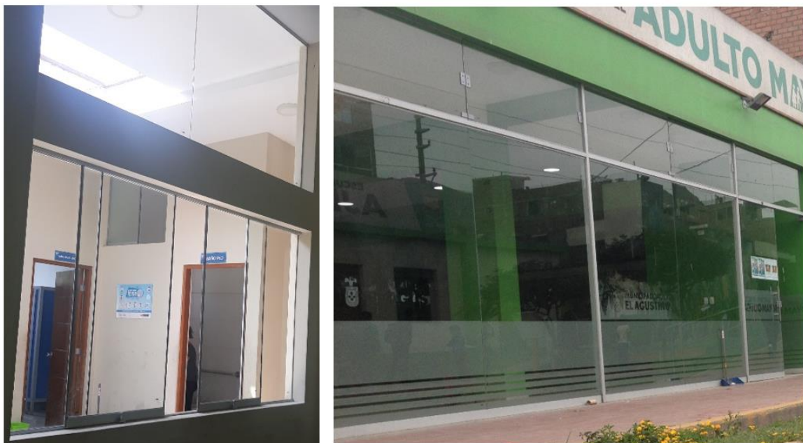
Figura 146. Acceso de iluminación natural del CIAM El Agustino. Fotografías tomadas por el autor
