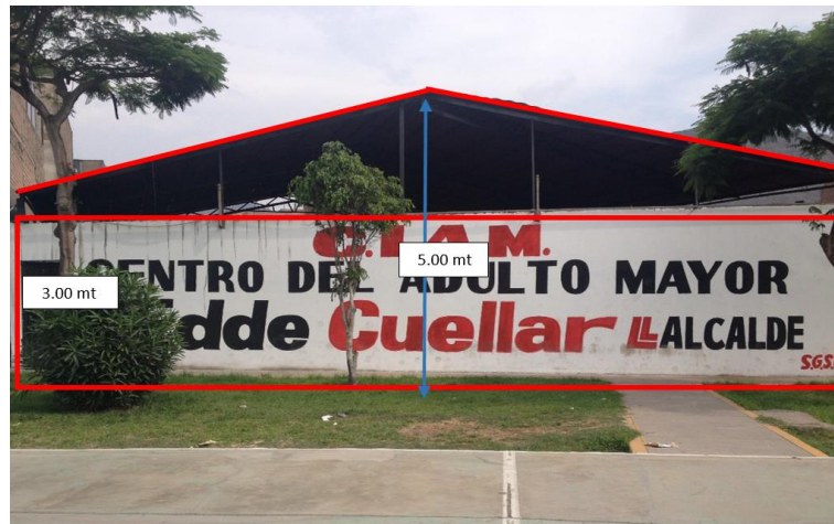
Figura 81. Fachada del CIAM de Ate Fotografía tomada por el autor
