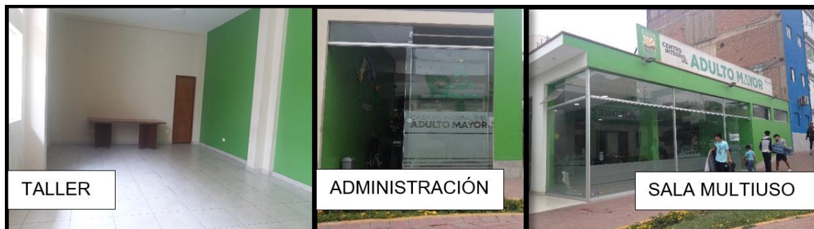
Figura 139. Infraestructura del CIAM de El Agustino Fotografías tomadas por el autor
