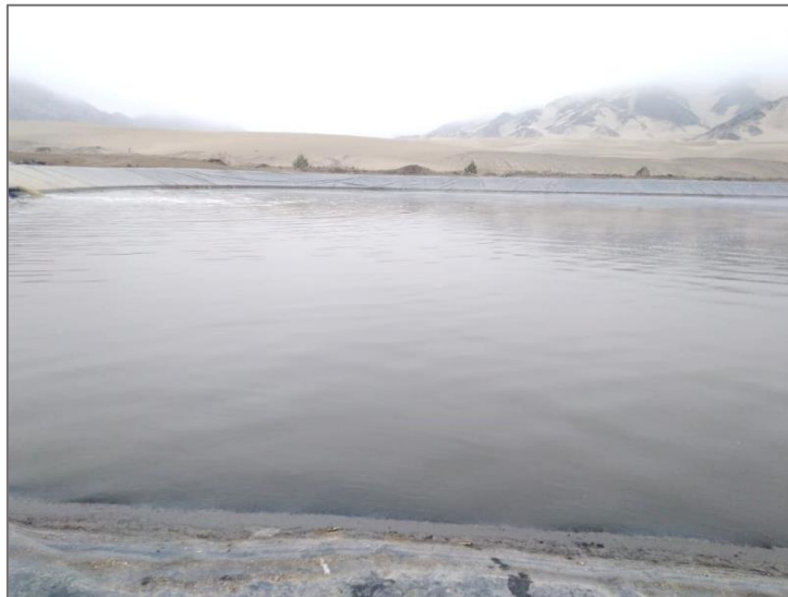
Figura 9: Laguna N°1 de Oxidación de Yaurilla
