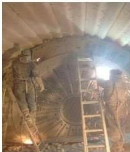
Foto 9 ventilación inapropiada
