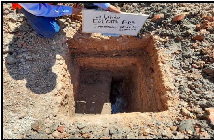
Se observa el perfil estratigráfico de la calicata
