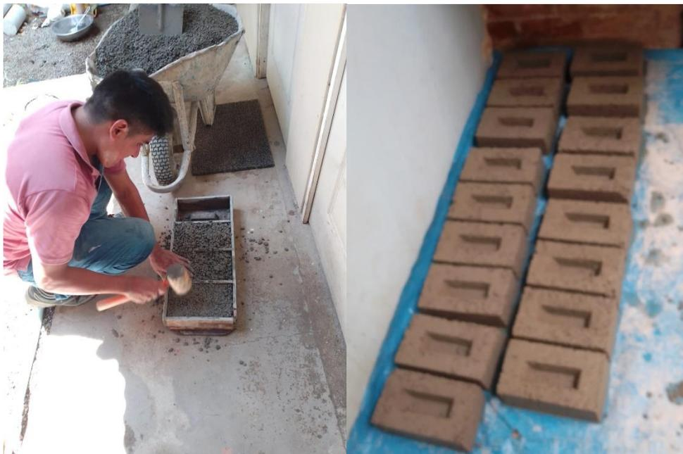
**Figura 10.** Fabricación de ladrillos de concreto
