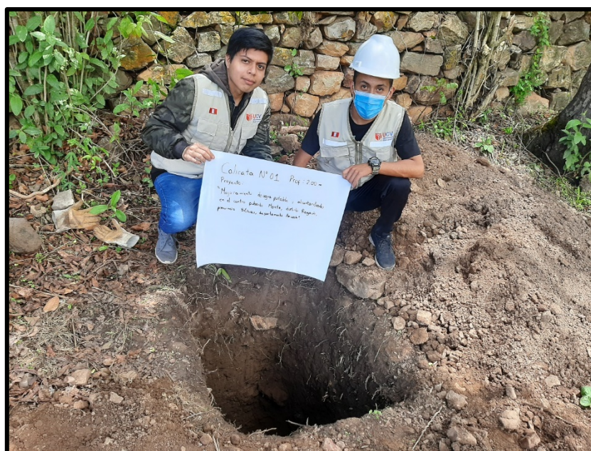
Figura 40. Evidencia de calicata
